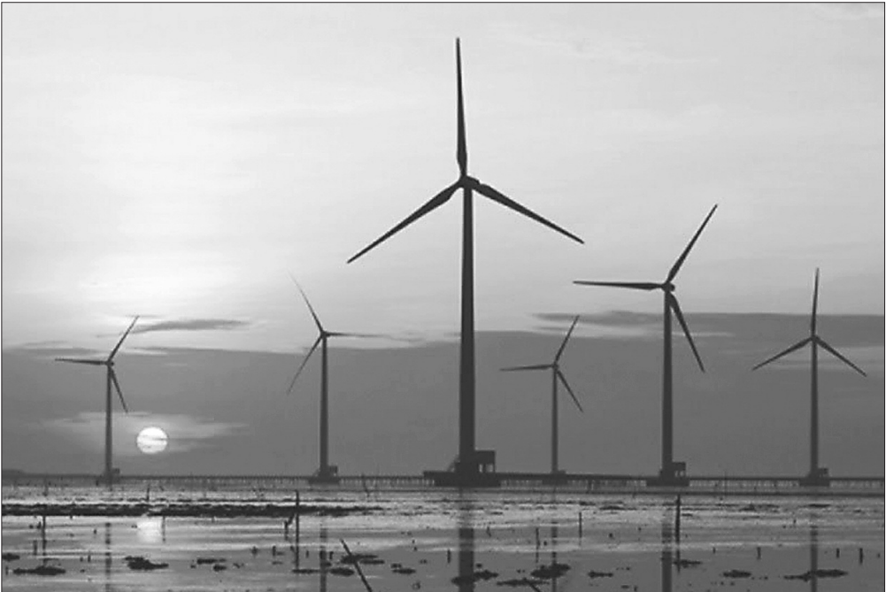
Nhà máy điện gió Bạc Liêu đặt tại xã Vĩnh Trạch Đông, TP Bạc Liêu, được xem là công trình điện gió lớn nhất cả nước _ Ảnh: vnexpress.net
